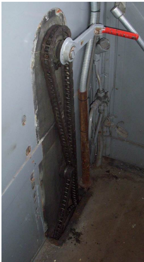
Figura 6-18 – Trasmissione a catena con azionamento a manovella esistente
