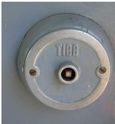
Figura 11-2 – Meccanismo isolamento porte
